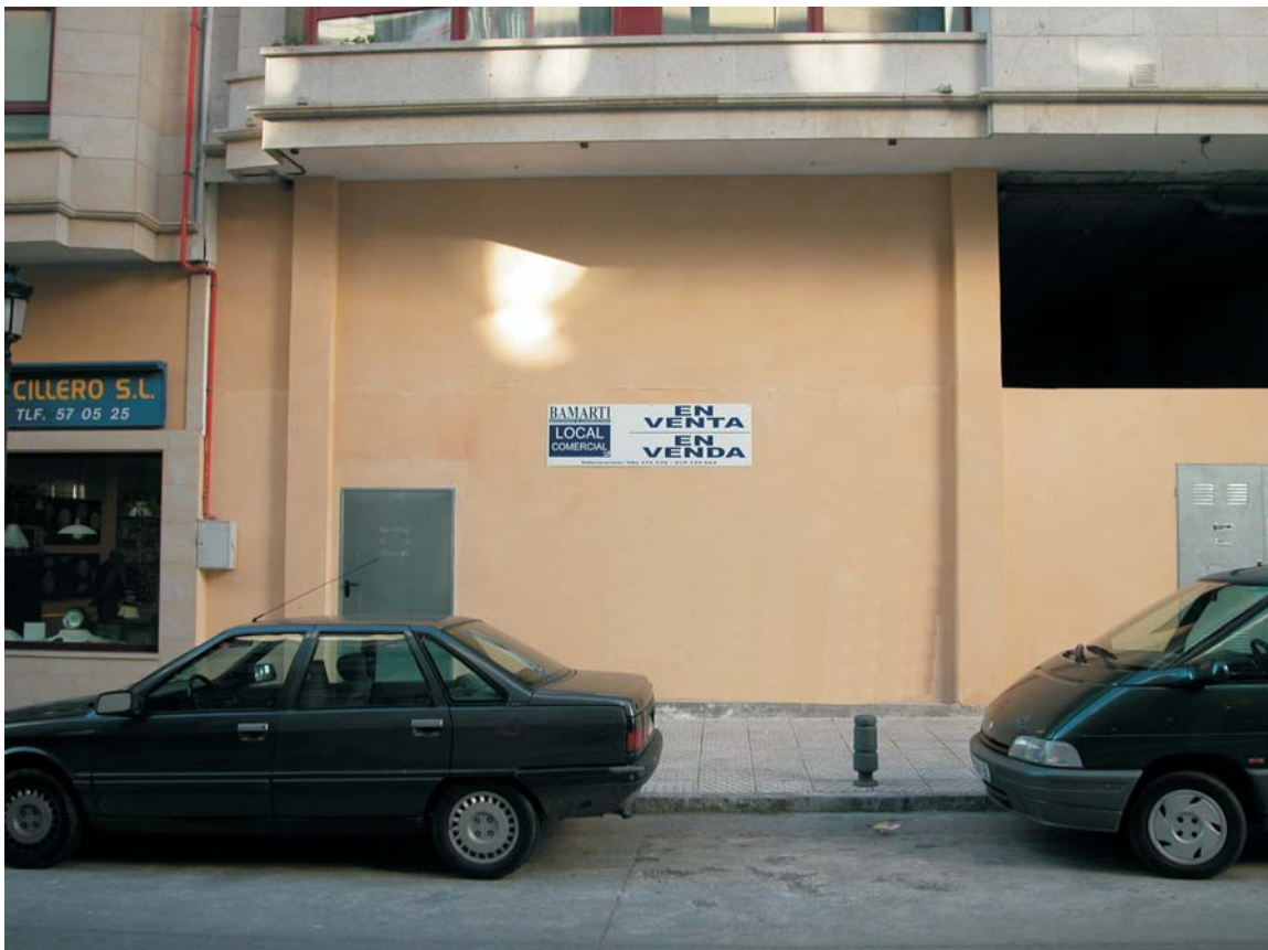
BAIXO COMERCIAL EN EDIFICIO SAN ANTÓN I.
