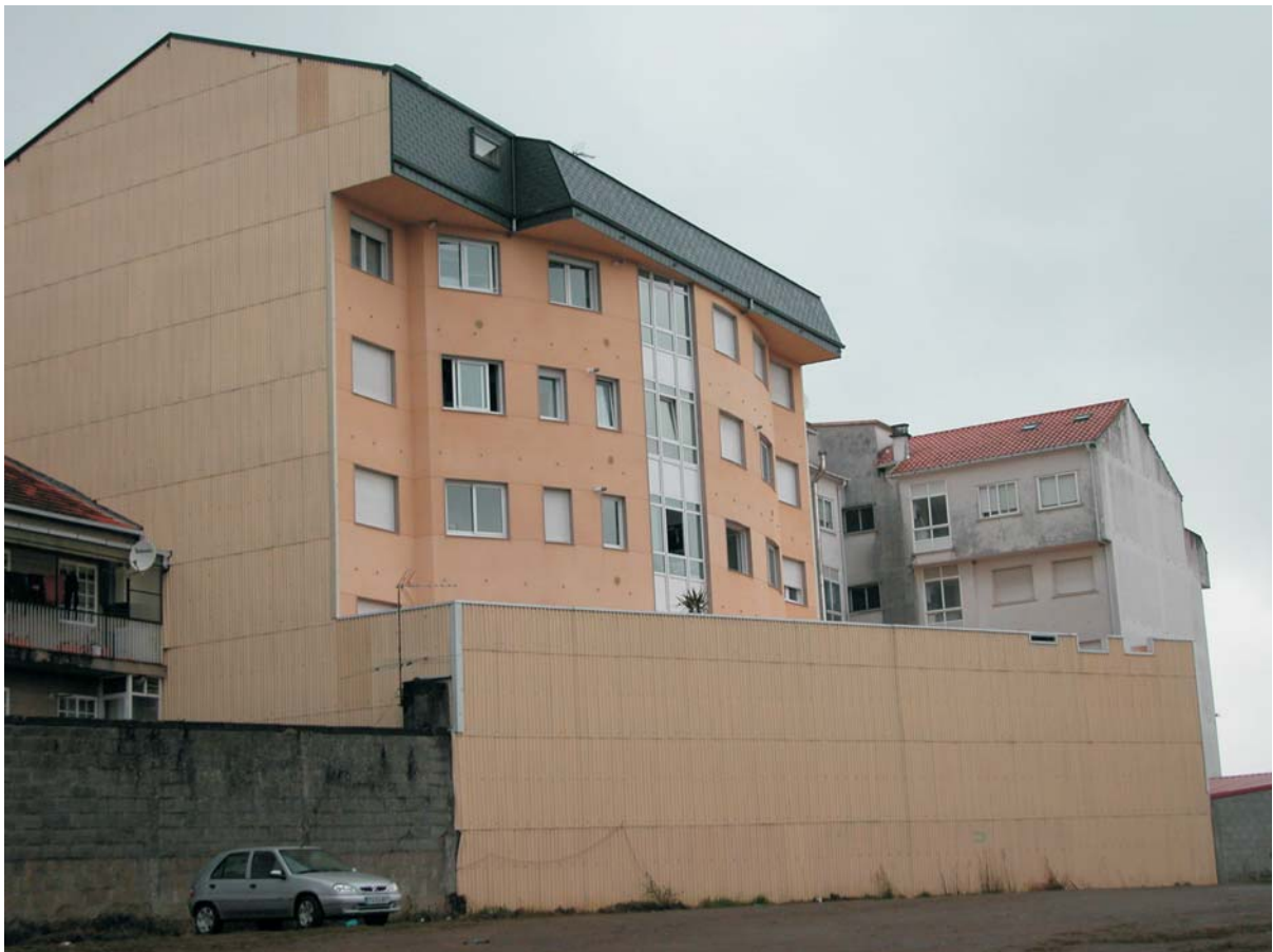
FACHADA POSTERIOR DO EDIFICIO
